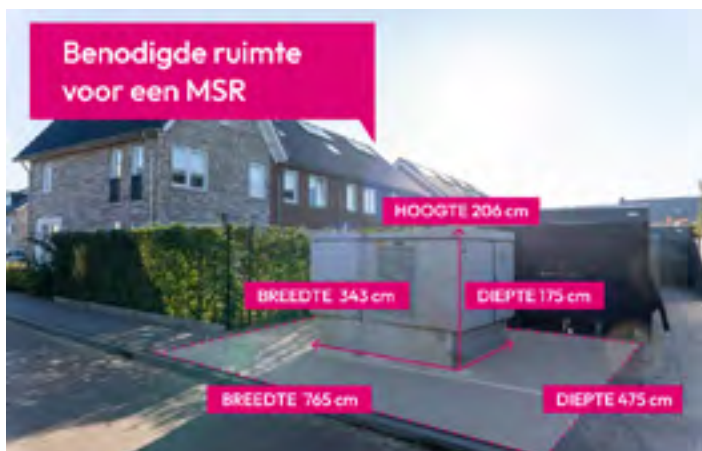
Figuur 5. Afmetingen MSR Enexis (206 H x 765 B x 475 D (cm), 36 m 2 )
