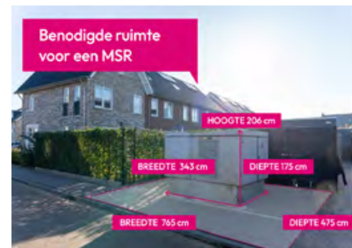
Figuur 4. Afmetingen MSR Enexis: 206 H. x 765 B. x 475 D. (cm), 36 m 2
